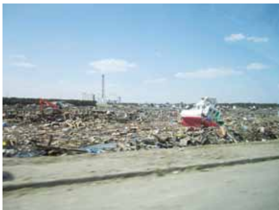
相馬市原釜地区の被災状況(H23.4.12撮影)
