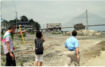
Visite du port Haragama pour constater les dégâts
